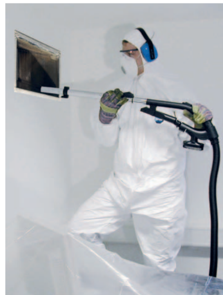
Die Reinigung erfolgt unter Zuhilfenahme spezieller Reinigungstechnik.
