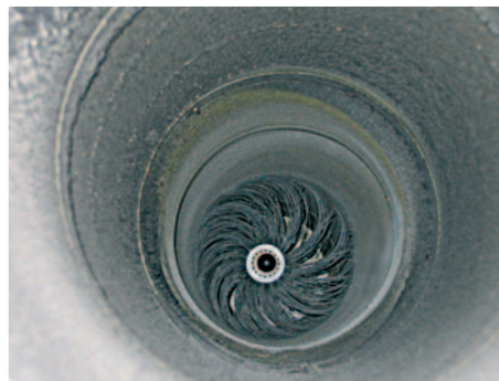
Reinigung der Abluftanlage
