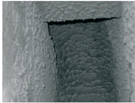
Verunreinigte Abluftanlage
